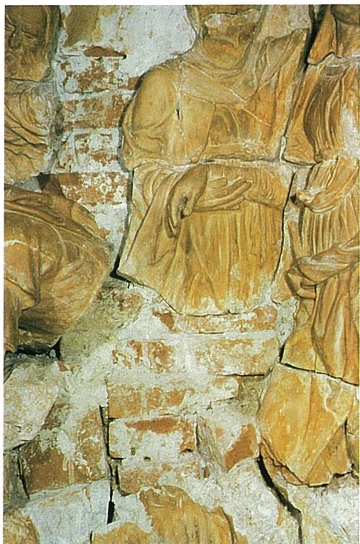
Fig. 9 - Esempio di lacuna strutturale, attorno alla "Pia Donna" che sorregge Maria, anticamente riempita con mattoni (a), durante lo smontaggio (b) e durante la prima fase della ricostruzione della lacuna in resina (c).
